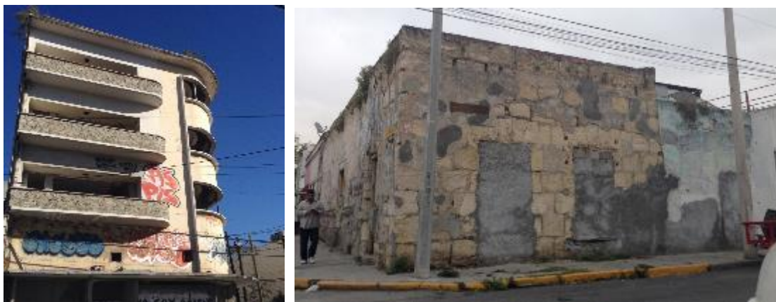
Figuras 24 y 25. Edificaciones en evidente estado de abandono
