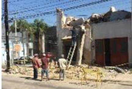
Figuras 19, 20 y 21. Inmuebles en evidente estado de abandono
