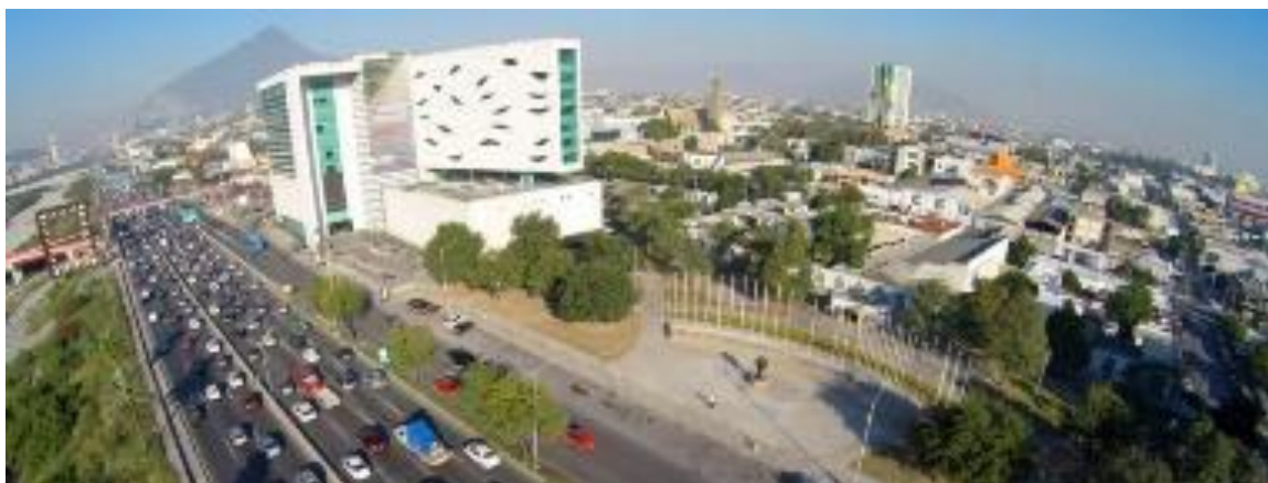
Figura 4. Corredor Avenida Constitución
