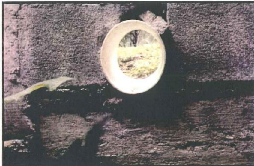
Figura 9. Imagen de un tubo colocado a manera de dren en la barda perimetral del predio vecino con el fin de permitir el desalojo del agua hacia el predio en estudio.
