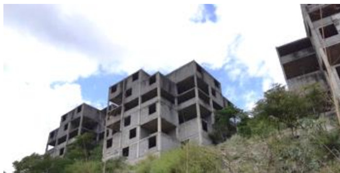
Figura 20. Vista de edificaciones abandonadas (Cerro de la Campana)
