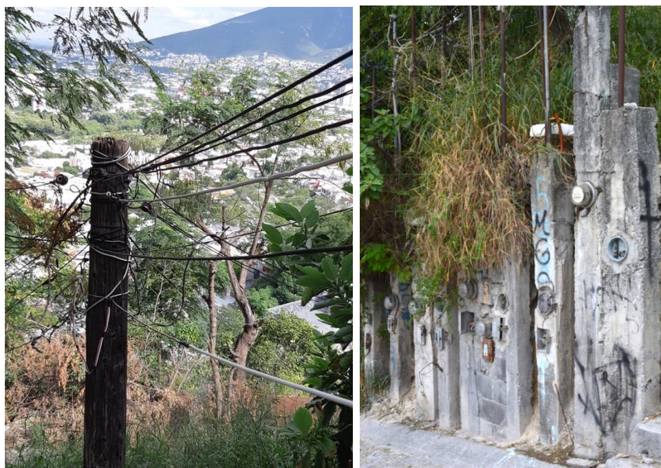
Figura 46. Vistas de instalación eléctrica en la zona
