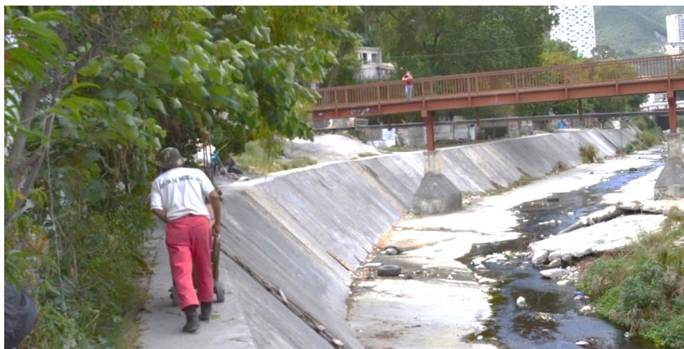
Figura 9. Vista del estado actual de la canalización del Arroyo Seco
