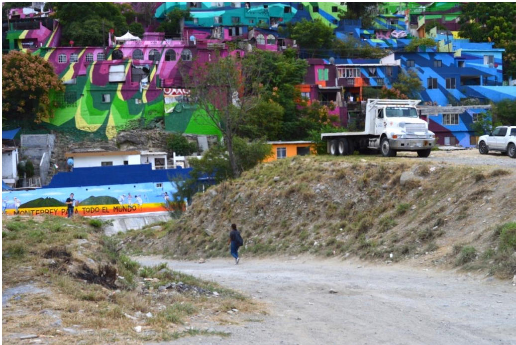
Figura 28. Vista de calle sin pavimentar
