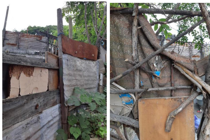
Figura 50. Vistas de vivienda autoconstruida con materiales de recuperación
