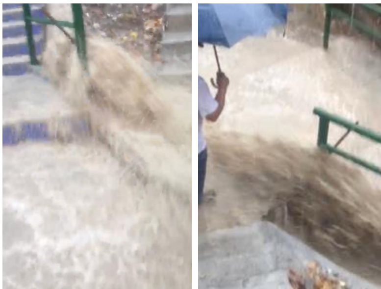
Figura 54. Condiciones típicas de andadores y escaleras convertidos en corrientes de bajantes pluviales
