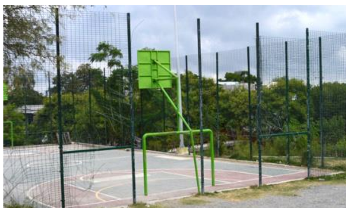
Figura 41. Vista de cancha deportiva desmantelada en Parque San Marcos
