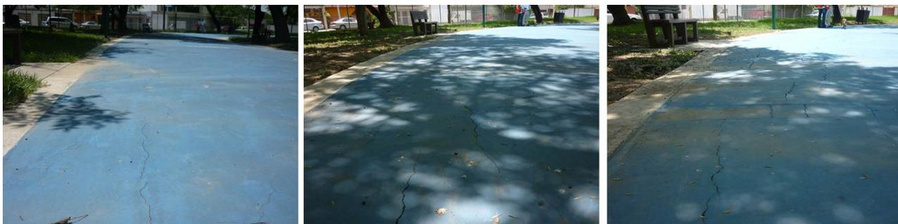
**Agrietamientos en el hombro exterior de la carpeta asfáltica aplicada en la vitapista.**
