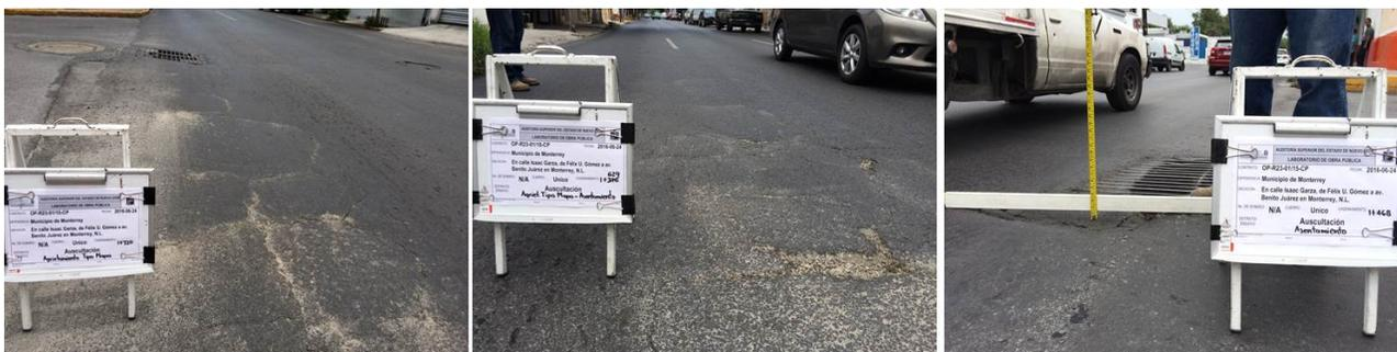
Agrietamiento tipo mapa en el cadenamamiento 1+320 (imagen izquierda); agrietamiento tipo mapa y asentamiento en el cadenamamiento 1+629 (imagen central); y asentamiento en el cadenamamiento 1+468 (imagen derecha).
