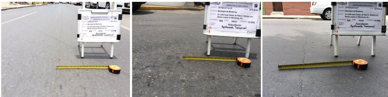
Agrietamiento longitudinal en el cadenamamiento 1+218 (imagen izquierda); agrietamiento transversal en el cadenamamiento 1+272 (imagen central); y agrietamiento transversal en el cadenamamiento 1+293 (imagen derecha).
