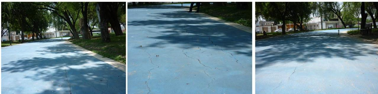
**Agrietamientos en el hombro interior de la carpeta asfáltica aplicada en la vitapista.**
