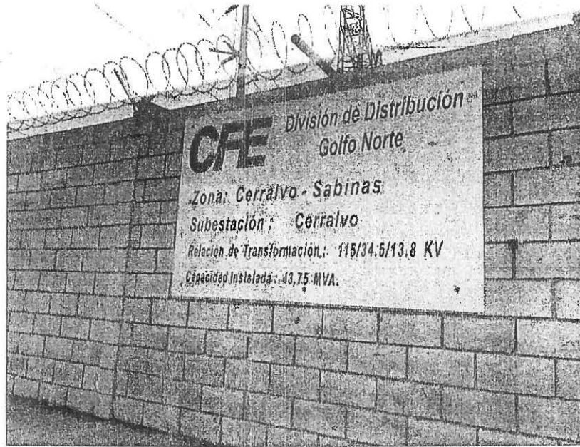
FIGURA 3. Placa de la subestación eléctrica Cerralvo.
