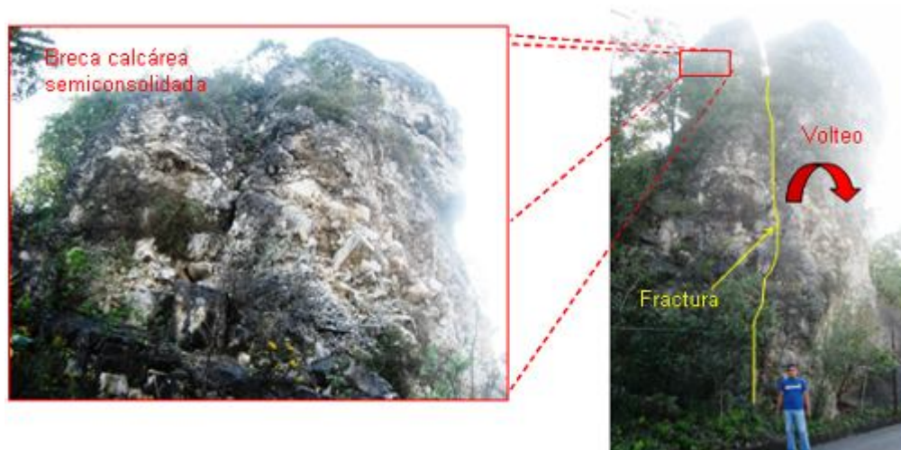
Fotografía 13. La fractura señala un bloque con una alta posibilidad de deslizamiento de la brecha.
