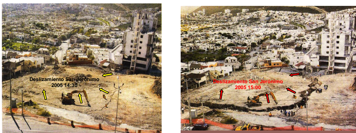
Fotografía 9. Deslizamiento rotacional en la colonia San Jerónimo en 2005.
