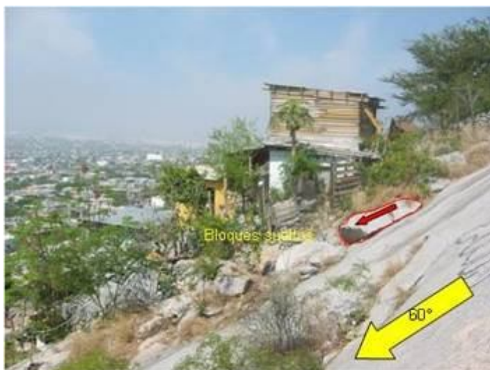
Fotografía 10. Deslizamiento capa a capa o planar.
