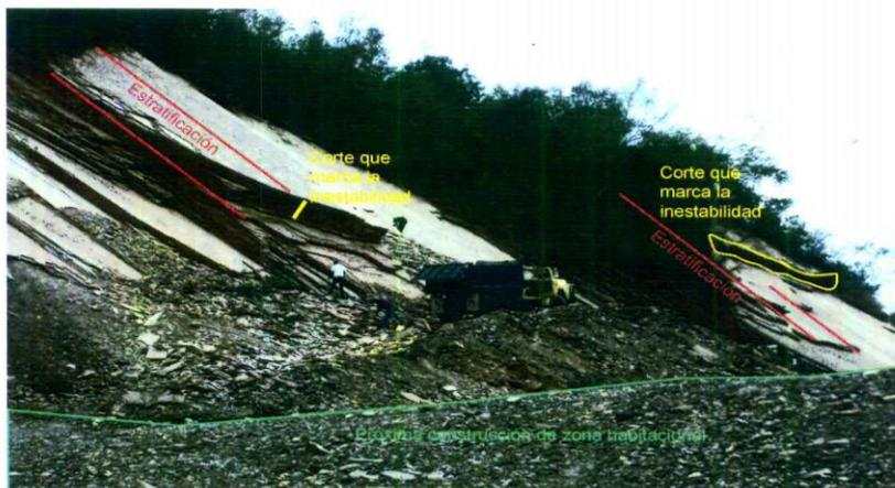
Fotografía 5. Inestabilidad de una ladera: tanto la inclinación de la ladera como la de la discontinuidad son paralelas; los cortes que se han efectuado aceleran el deslizamiento por falla plana de los estratos.
