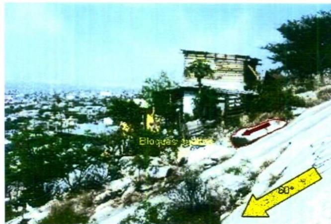
Fotografía 10. Deslizamiento capa a capa o planar.
