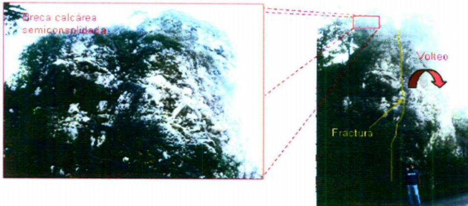
Fotografía 13. La fractura señala un bloque con una alta posibilidad de deslizamiento de la brecha.
