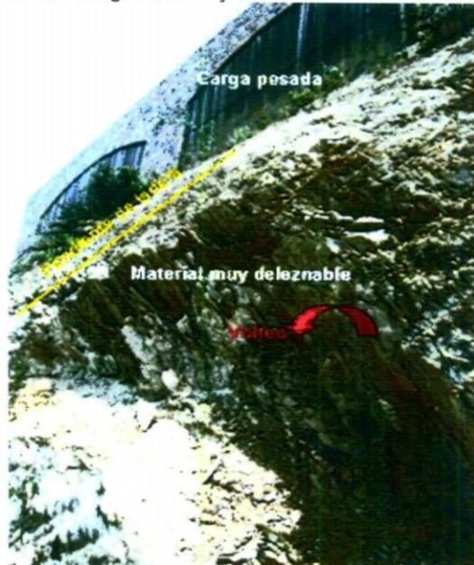
Fotografía 14. Áreas en alto riesgo dada la presencia de material muy intemperizable
