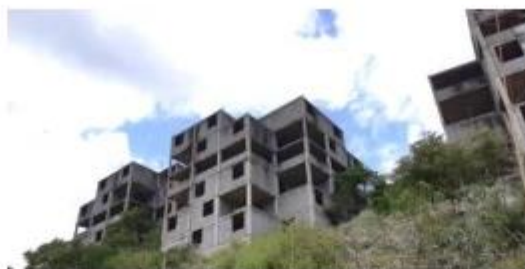
Figura 20. Vista de edificaciones abandonadas (Cerro de la Campana)
