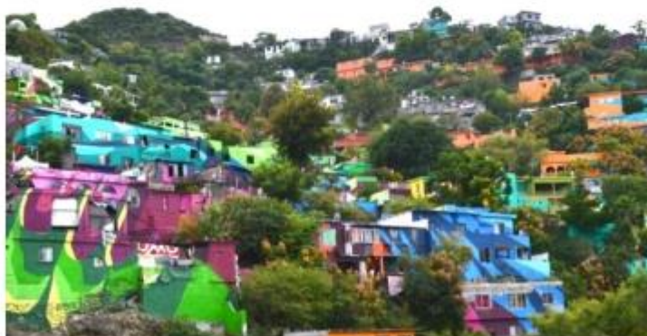
Figura 8. Vista de asentamientos ubicados en zonas de pendiente pronunciada
