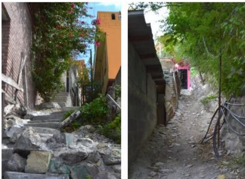
Figura 31. Vistas de condiciones típicas de andadores peatonales
