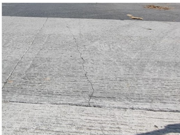
Imagen izquierda, falla número 3, agrietamiento en esquina en el cadenamiento 0+544; Imagen derecha, falla número 2, agrietamiento longitudinal en el cadenamiento 0+544, sobre carpeta de concreto hidráulico de la calle Vaqueros.
