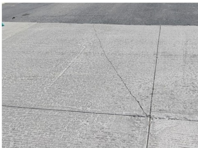
Imagen izquierda, falla número 3, agrietamiento en esquina en el cadenamiento 0+544; Imagen derecha, falla número 2, agrietamiento longitudinal en el cadenamiento 0+544, sobre carpeta de concreto hidráulico de la calle Vaqueros.
